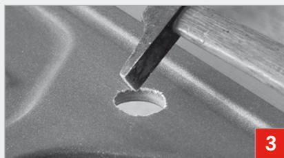
■ Placer l'évier dans la découpe du plan de travail. **Sur le dessus de l'évier**, au niveau de la pastille de repérage, frapper d'un coup sec à l'aide du pointeau et du marteau.
