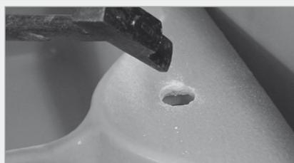
■ Placer l'évier dans la découpe du plan de travail. **Sur le dessus de l'évier**, au niveau du point de repérage, frapper par coup successifs à l'aide du pointeau et du marteau
