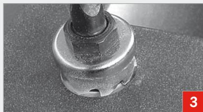
■ **Sur le dessous de l'évier**, percer un trou à l'aide du foret de la scie cloche au niveau de l'amorce conique.
